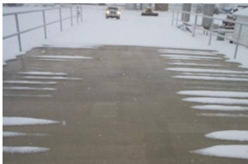
Geotermia para evitar el hielo en la calzada.
