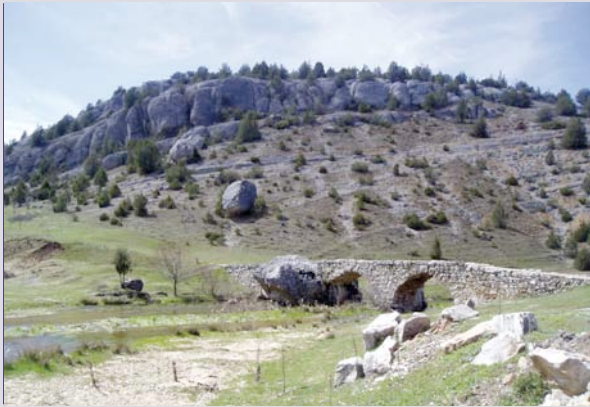
Desprendimiento de bloques en la zona del puente Campanario (J. Preciado).
